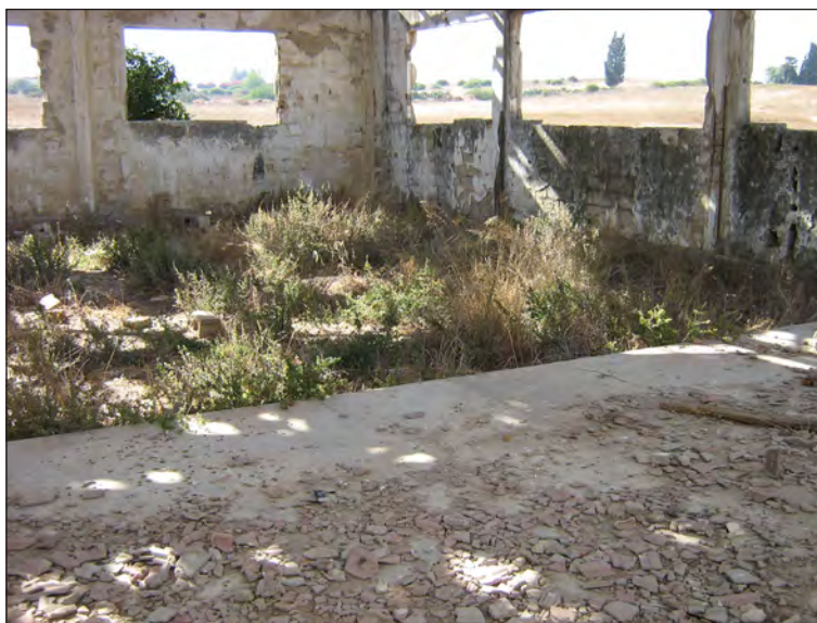
איור 7: תצלום הרצפה בתוך בית האריזה. לצד רצפת בטון מוגבהת ניתן להבחין בקרקע חשופה שבעבר הונחה עליה רצפת עץ מוגבהת. מתחת לגובה מפלס רצפת העץ ובתוך הקירות מבחינים בפתחי אוורור מלבניים
